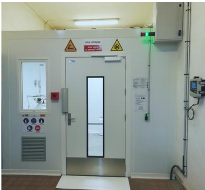
Figure 2 : Sécurisation à l'entrée d'une salle azote : exemple du CHU de Lille
